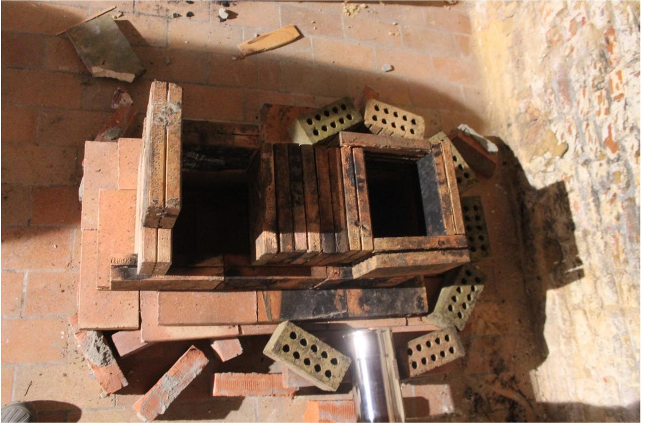
Prototype servant de modele au futur Rocket mass heater !
